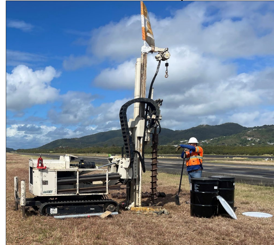
Instalación de pozos de monitoreo
