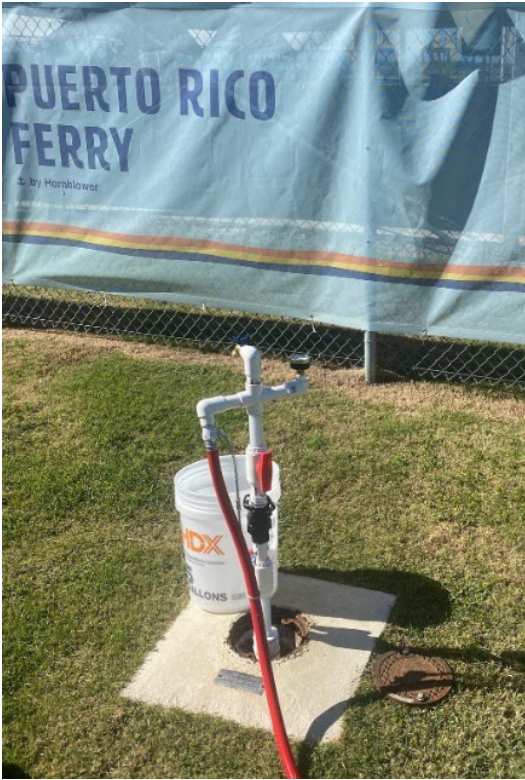
Cabeza de pozo de Inyección
