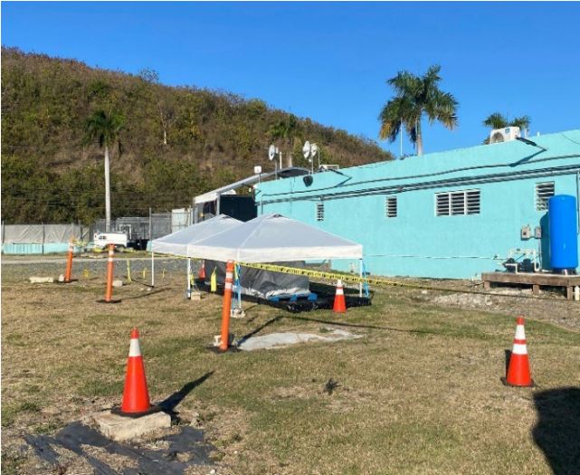
Carpas sobre los contenedores de EVP
